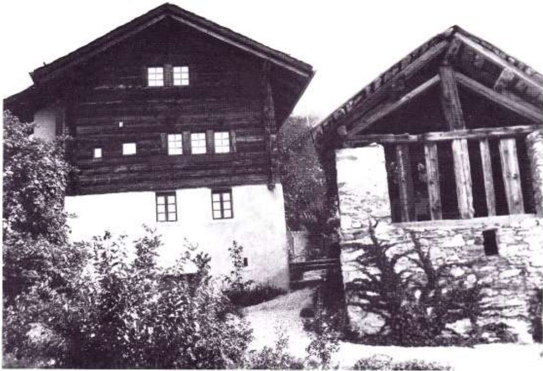
Maison d'habitation et grange
